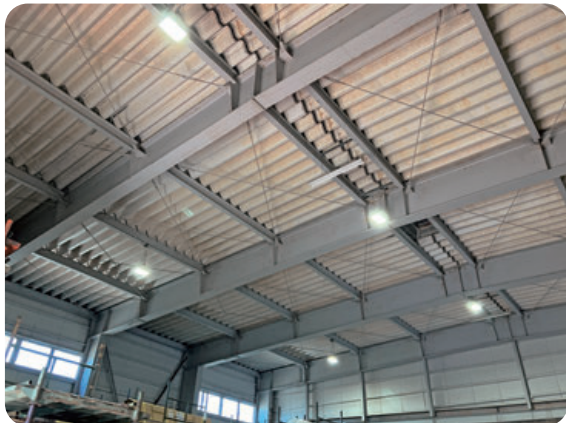
工場倉庫の水銀灯のLED化
